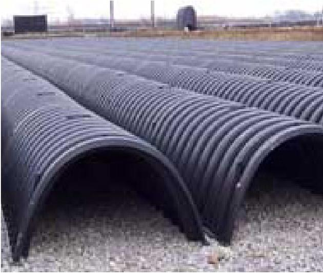
SUBSURFACE STORAGE OR INFILTRATION
